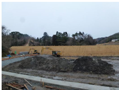
集団移転先の造成工事を視察
