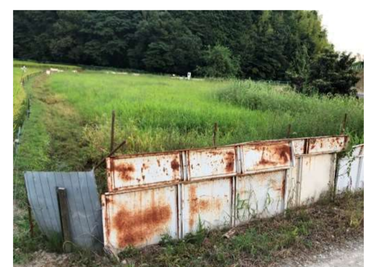
トタン板の防除柵
