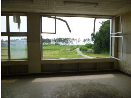
鳴瀬第二中学の窓から見る野蒜海岸
