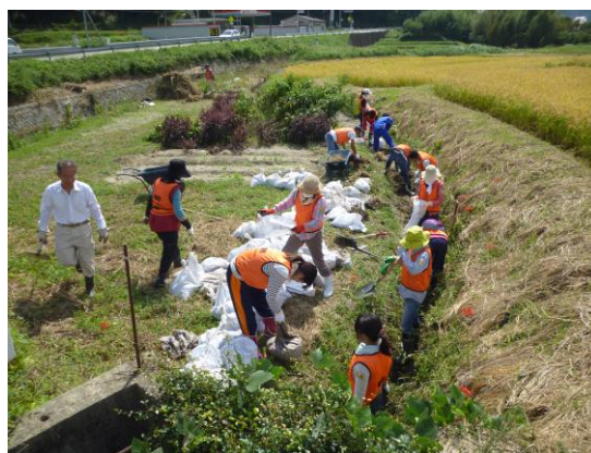
農地の共用水路での土砂撤去作業
