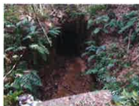
写真1 マンボ入口(St.1)
