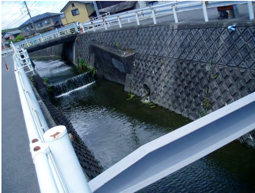
北鵜町ごみ置き場から上流を見る。朝明川導水なし、流量は多め
