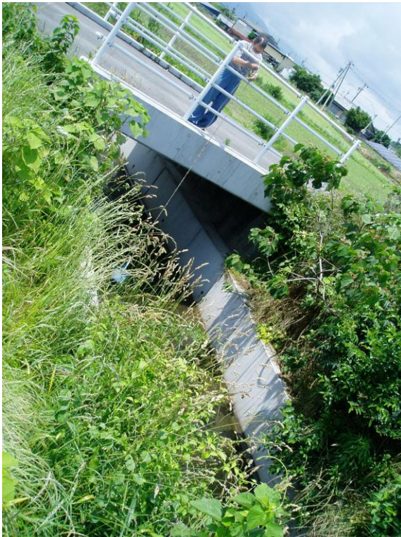
大口川上流部用水路(Mi 農場そば排水口の上流付近)
