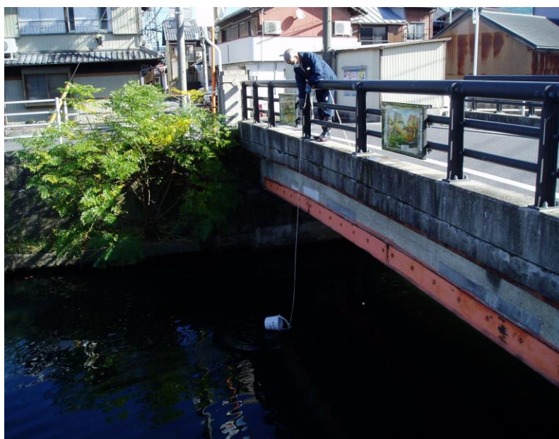
十四川最下流部の豊栄橋で採水作業、閘門閉鎖滞留中（下は川底）
