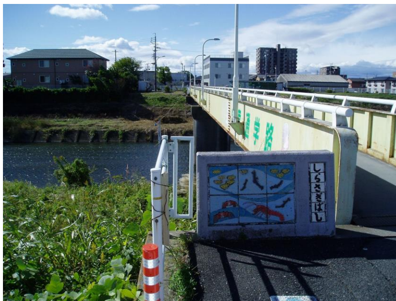
海蔵川中下流のしらさぎ橋での採水(川幅は広い)
