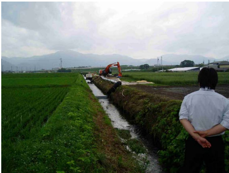
大口川周辺の養豚場付近の用水路改修工事
