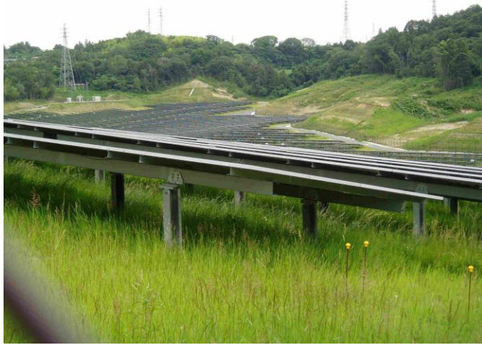
西側より南東方向の変電装置と中電の送電線を望む
