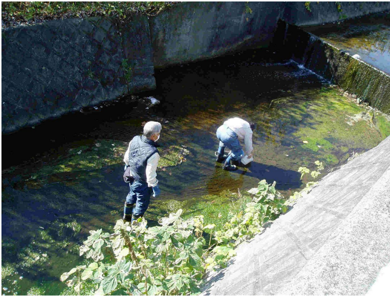
富田山城道路沿いの中流部サンシの下流で、藻類繁茂
