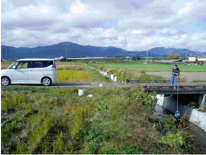
大口川の上流部の用水路(雅農場そば)の河川改修工事完了
